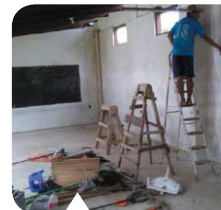
De werkzaamheden zijn in volle gang.
