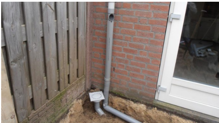
Afvoer onder de grond (op bestaande HWA)
