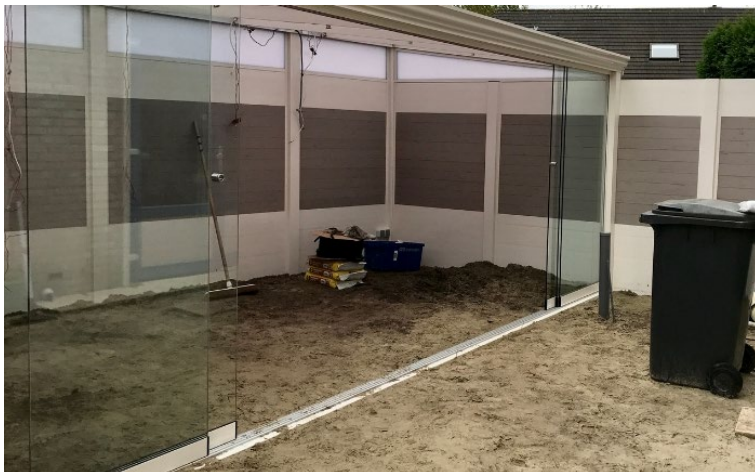
Kokerfundering onder glazen schuifwand
