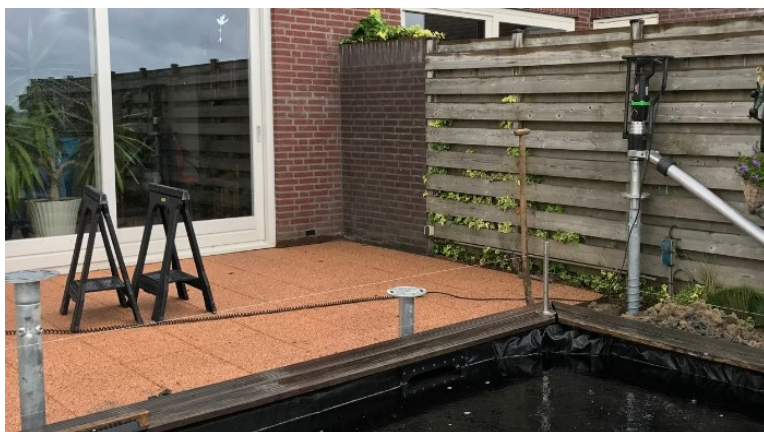
Schroeffundering met indraaimachine
