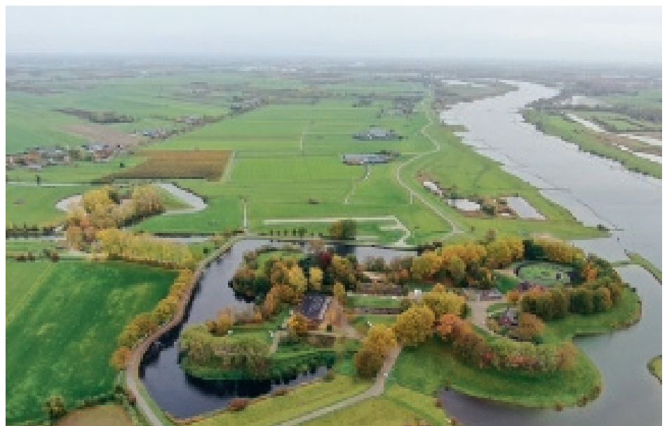
Duurzame innovaties zoals een emissieloze materieelpool worden toegepast op de gehele Lekdijk, waaronder deeltraject 6 bij het fraaie Fort Honswijk bij Houten
