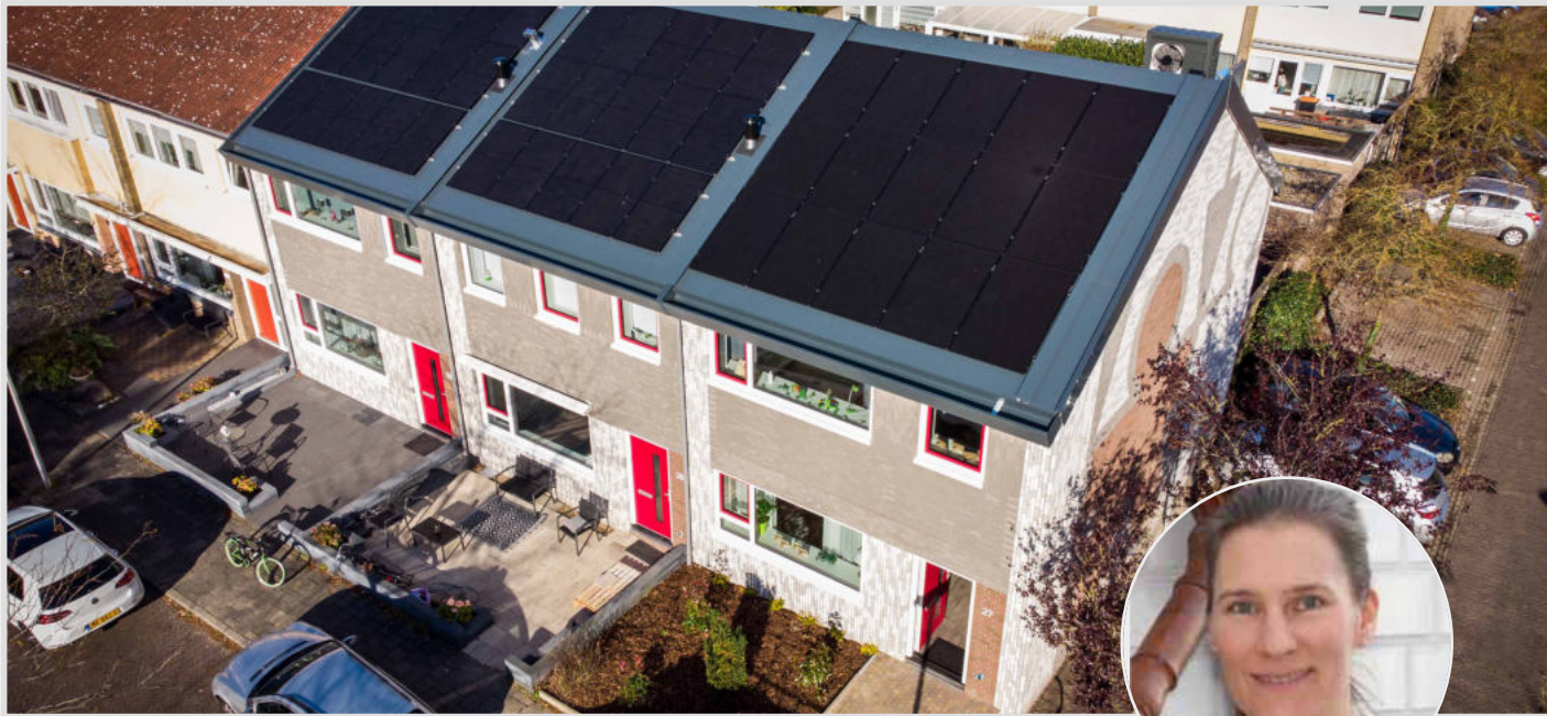
Bild: Montage eines INDU-ZERO-Wandpanels an einem Reihenhhaus in den Niederlanden
