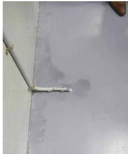
Figuur 5-14 Voorbeeld uitloop pigment.
