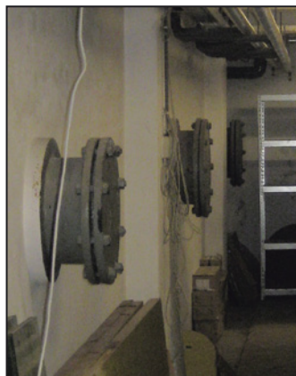
37 AB Sporen van de buizen in de kelder (2015).
