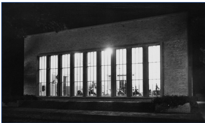
21 De vier hogedrukpompen achter de negen vensters (1954).
