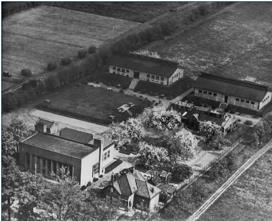
20 Luchtfoto van het pompstationcomplex, met hooiwagens op de achtergrond (omstreeks 1950).
