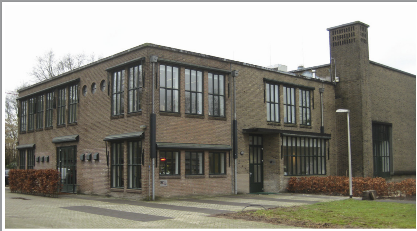
34 Oostzijde van het achtergebouw (2015).
