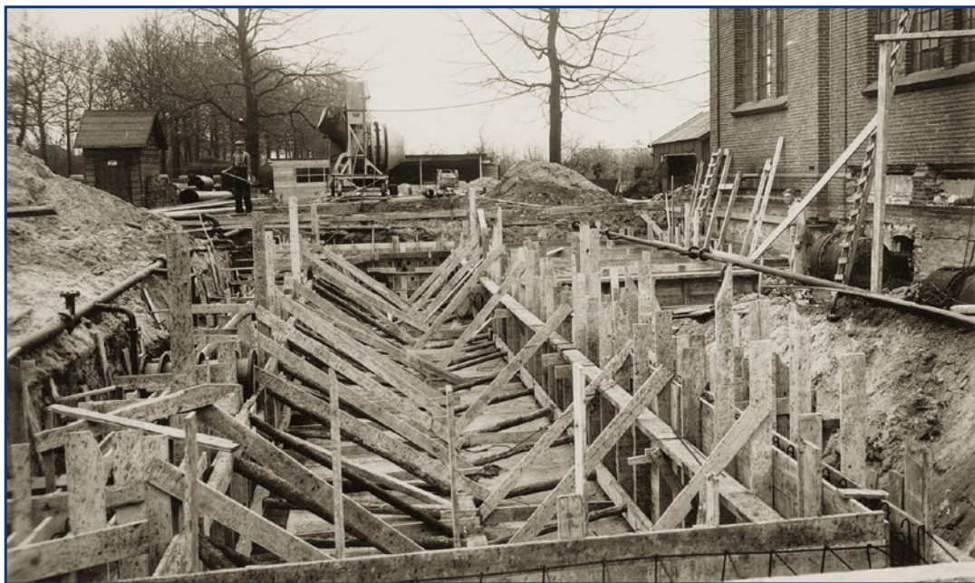
📍 Aanleg van de kelder (1936).
