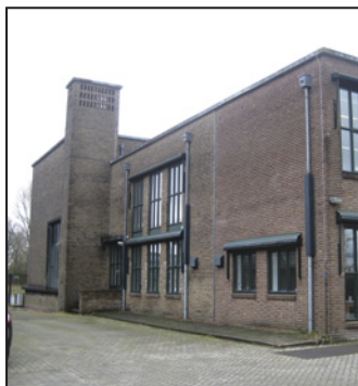
32 Westzijde van het achtergebouw (2015).
