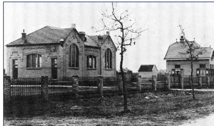
5 Pompgebouw en dienstwoning uit 1912.
