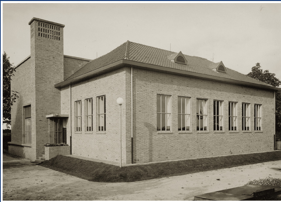
12 Nieuwe achter- en zijkant van het oude gebouw (1954).
