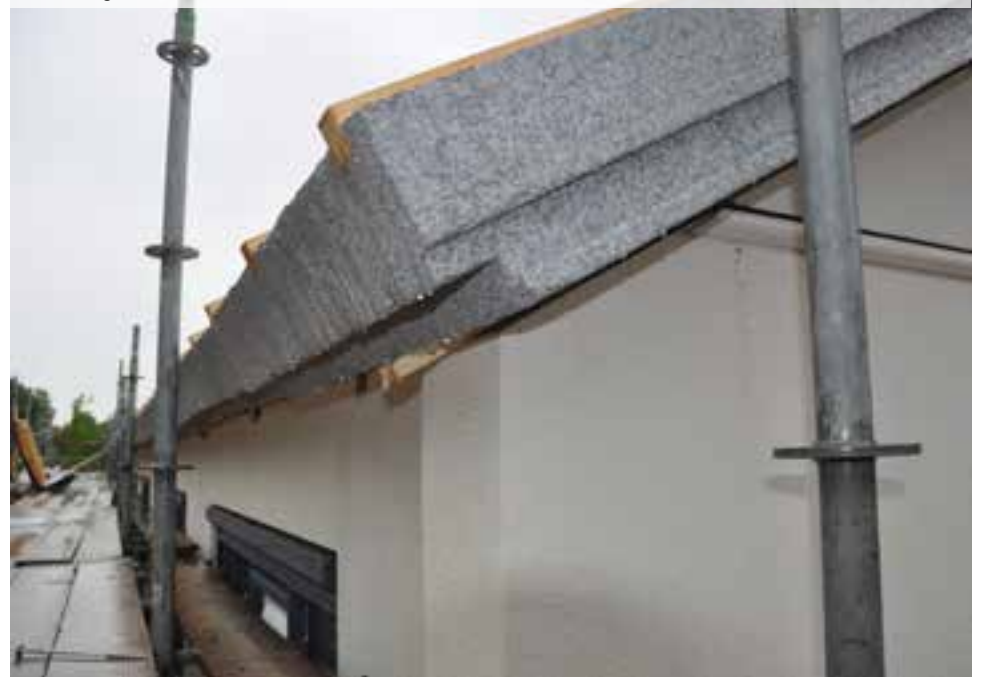
Eenvoudige realisatie van een overstek tot 50 cm.
