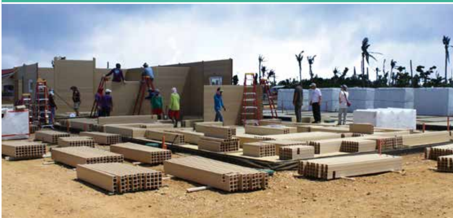
Noodhospitaal in Guiuan op de Filipijnen, opgebouwd uit Compodeen houtvezelcomposiet bouwdelen
