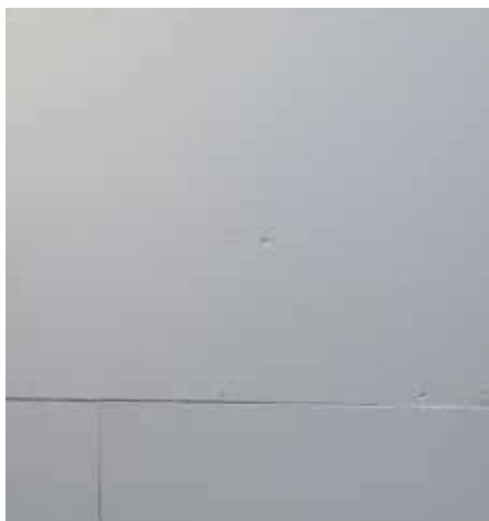
Unir les joints bout à bout | Ragréage avec RÖFIX Renopor® Mortier-colle et réagréage spécifique
