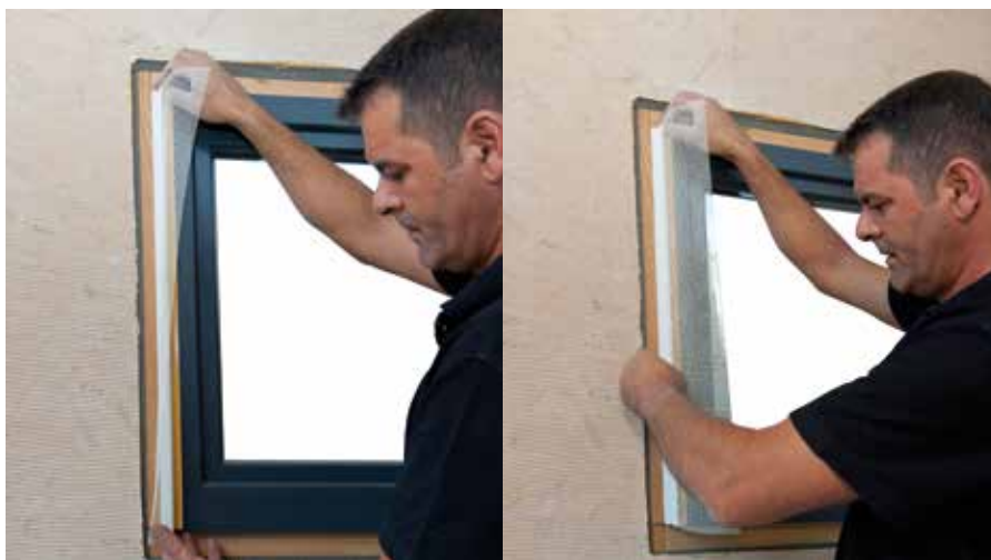
Positionner le profil à angle droit et le coller sur le châssis en bois situé en dessous
