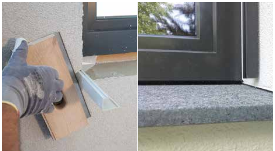
Rogner le profil de délimitation RÖFIX SOL-PAD avec l'outil RÖFIX SOL-PAD Tool en laissant 2 mm de saillie puis monter le rebord
