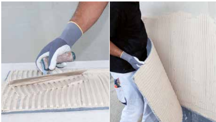
Appliquer l'enduit de collage sur le panneau isolant et sur le support, puis positionner le panneau isolant
