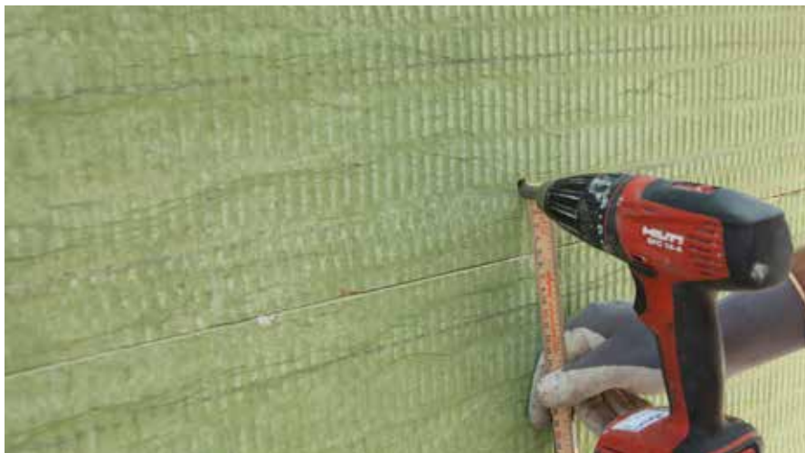
Les panneaux en laine minérale sont chevillés à une distance de 5 cm de l'arrête extérieure du panneau
