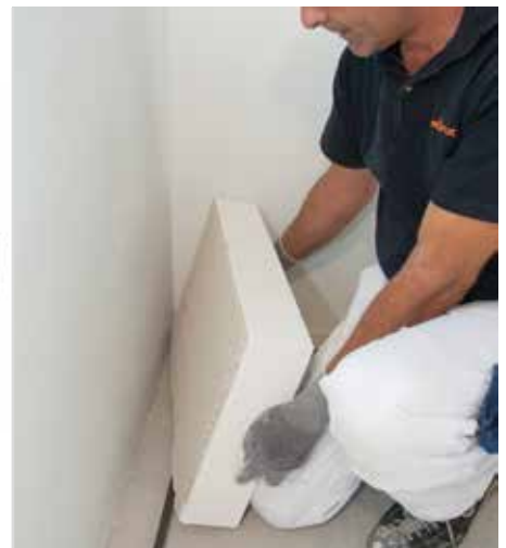
Application sur toute la surface de RÖFIX MINOSTAR® Bien presser les panneaux isolants
