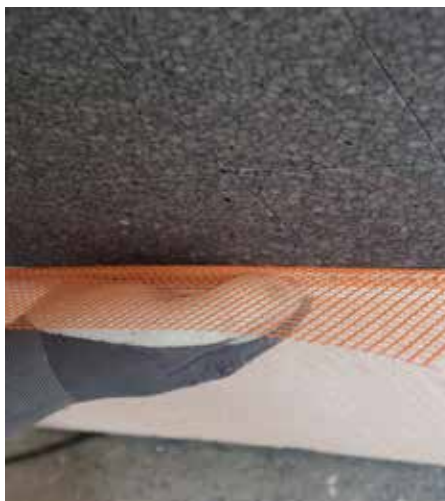
Insérer le profil à enclenchement pour socle RÖFIX
