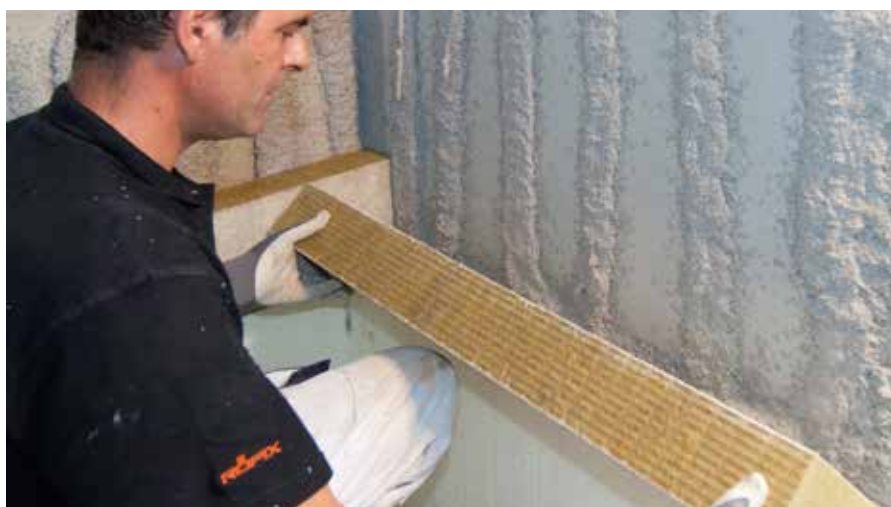
Bien appliquer les panneaux isolants RÖFIX SPEED MW en les pressant contre les bandes d'enduit de collage frais
