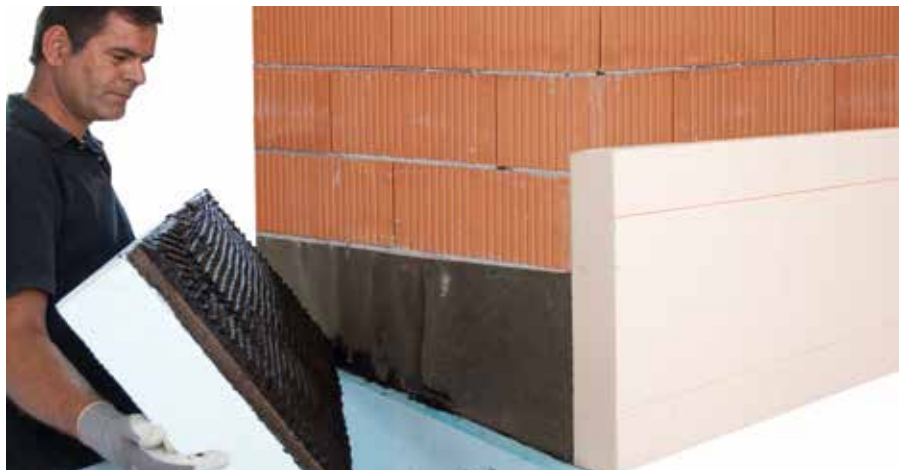
Coller à pleine surface le panneau isolant pour soubassement RÖFIX EPS-P 035 sur le revêtement bitumineux en utilisant RÖFIX 1K Plus
