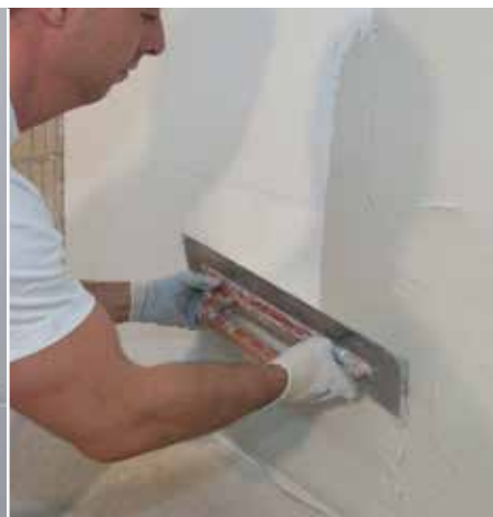
Ragréage avec RÖFIX Renopor® Mortier-colle et réagréage spécifique
