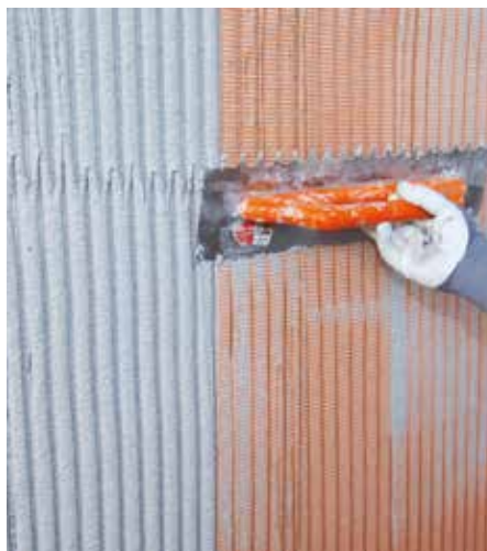
Appliquer l'enduit de lissage en une épaisseur nominale de 5 mm
