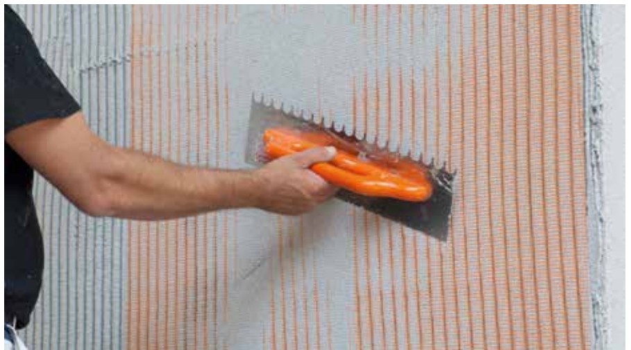
Appliquer RÖFIX Unistar® LIGHT en une épaisseur nominale de 5 mm et noyer le treillis d'armature RÖFIX P50
