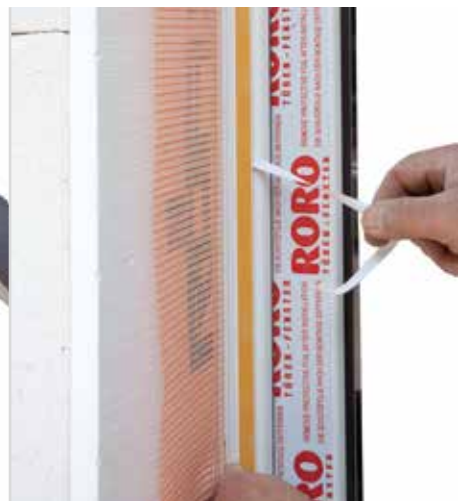
Coller RÖFIX MINI 3D sur le cadre de la fenêtre et protéger la fenêtre avant le ragréage
