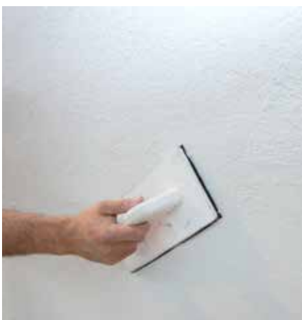
Structurer avec RÖFIX Renopor® Mortier-colle et réagréage spécifique
