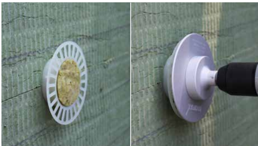
Insérer la cheville avec le plateau dans le trou et visser, puis couvrir avec la rondelle en laine de roche
