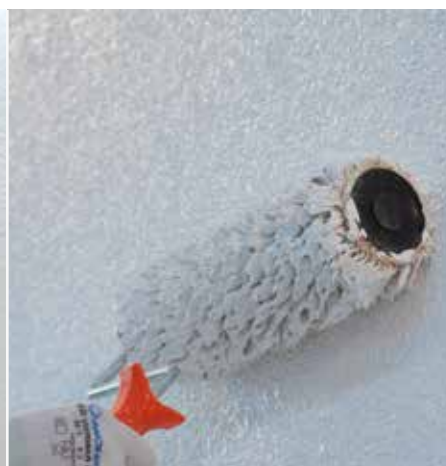
Revêtement avec des peintures perméables à la vapeur
