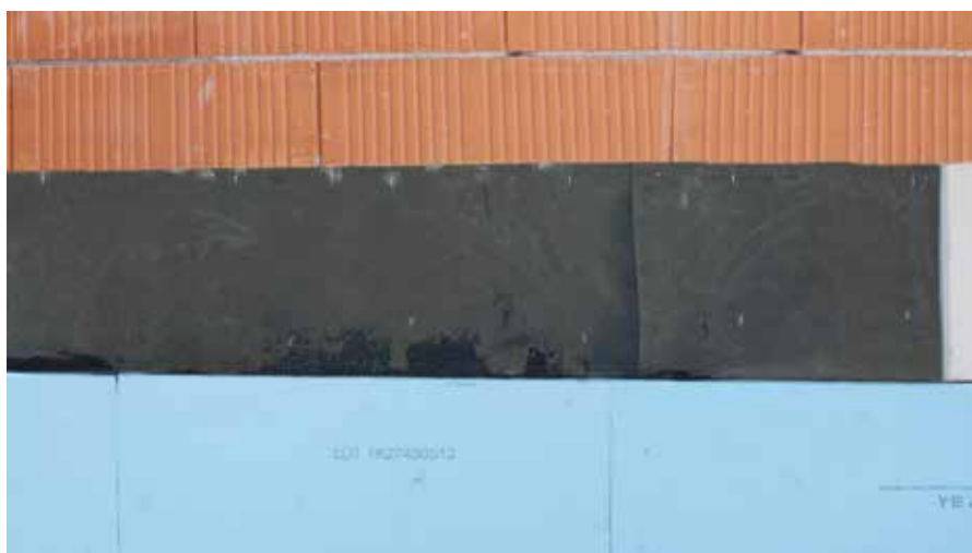
Panneaux isolants périmétriques collés avec l'adhésif bitumineux RÖFIX 1K Plus
