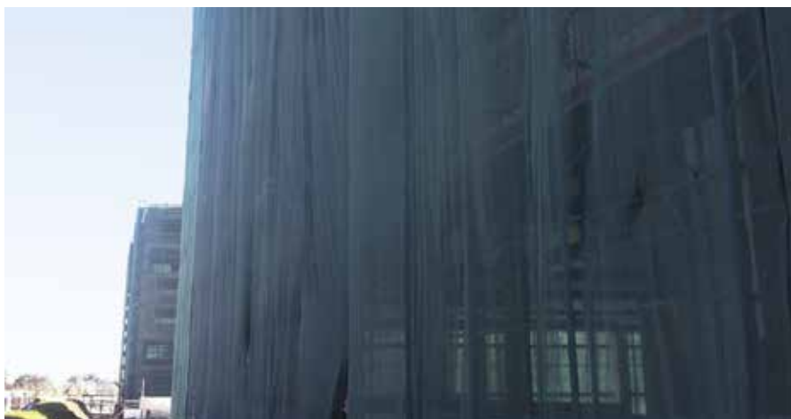
Le filet de protection de la façade protège les matériaux qui viennent tout juste d'être appliqués des agents atmosphériques et d'un séchage trop rapide
