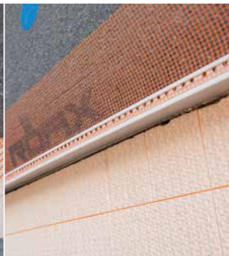
Régler le profil à enclenchement pour socle RÖFIX en fonction de l'épaisseur de l'isolant
