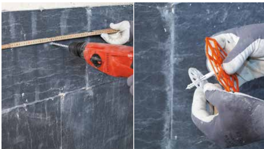
Positionner les chevilles selon un quadrillage de 40x40 et poser en suivant les instructions contenues sur l'emballage
