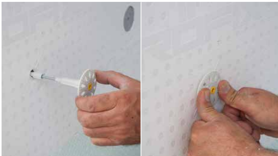
Montage à encastrement: Insérer RÖFIX ROCKET dans le trou. La tête de la cheville doit être placée au ras du panneau isolant.
