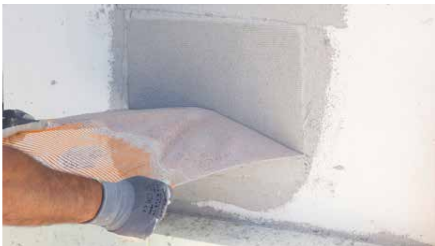
Retirer le treillis d'armature RÖFIX P50
