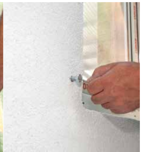
Il est possible de fixer l'élément souhaité avec une vis type M
