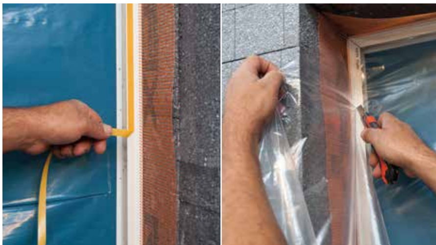
Retirer la bande jaune du profil qui est autoadhésif et protéger la fenêtre avec une couche de nylon
