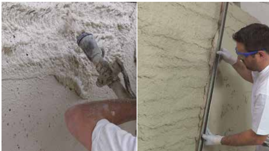
Application de l'enduit FIXIT 222 Aerogel
