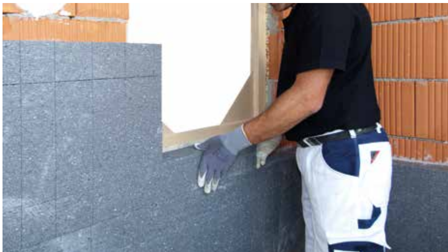
Au niveau des ouvertures, appliquer les panneaux isolants entiers découpés en forme de L
