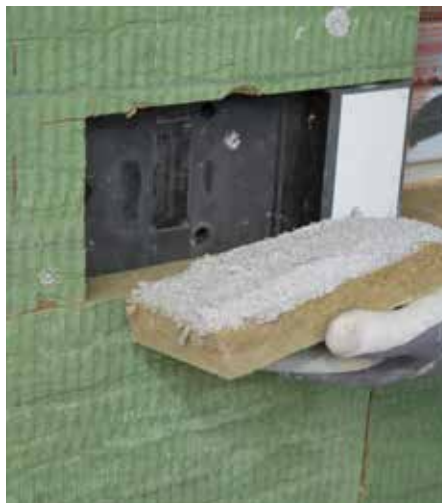
Coller/couvrir les chevilles avec un panneau isolant
