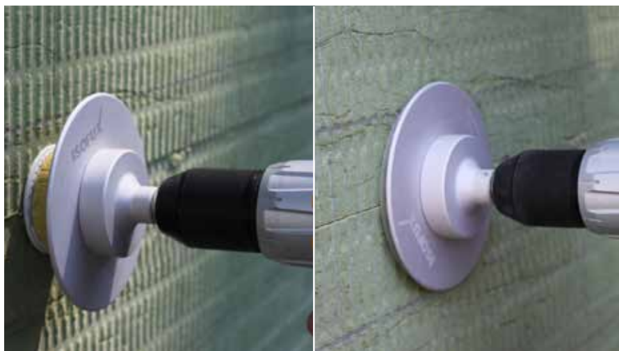
Enfoncer la cheville jusqu'à la butée en utilisant l'outil RÖFIX ISOFUX OPTI
