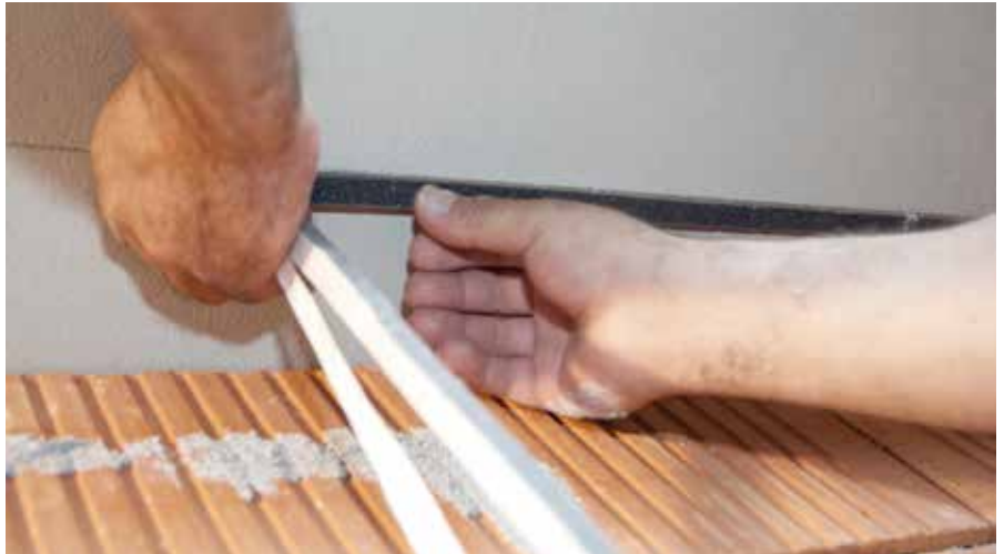
Coller le ruban d'étanchéité RÖFIX sur la partie située en dessous du balcon ou du recouvrement
