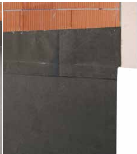
Imperméabilisation de la maçonnerie contre terre avec un revêtement bitumineux
