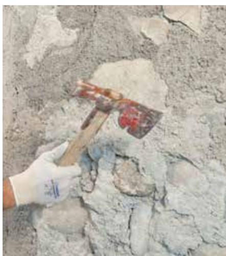
Élimination du vieux enduit
