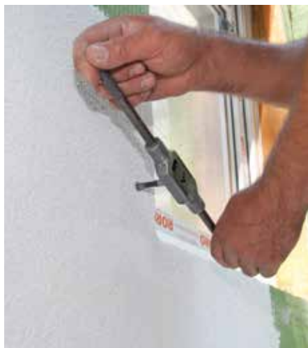
Réaliser le filetage
