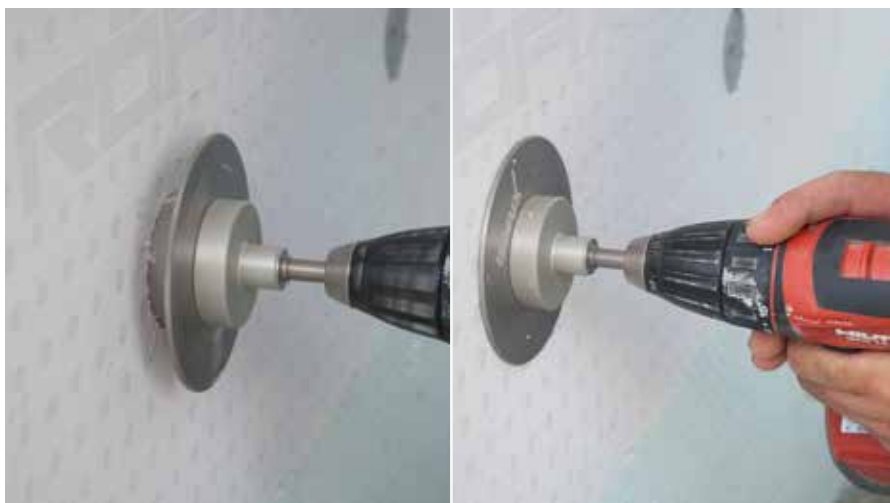
Montage à encastrement: Bien insérer le BIT dans le logement Torx jusqu'au déclic d'accrochage, puis laisser que la cheville s'« auto-visse » (sans exercer de pression).
