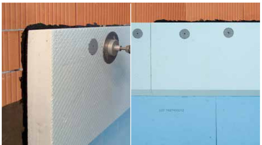
Fixer les panneaux isolants pour soubassement au-delà du niveau supérieur de l'imperméabilisation avec 2 chevilles par panneau
