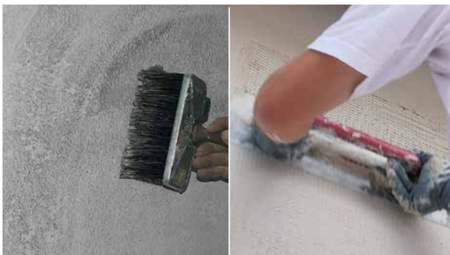
Fixation de la surface avec RÖFIX PP 201
