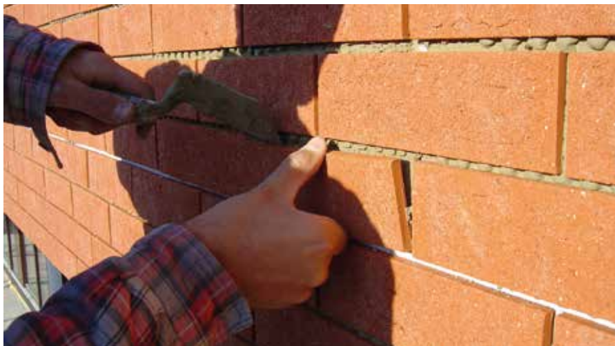
Coller les briques à pleine surface selon la méthode floating-buttering
