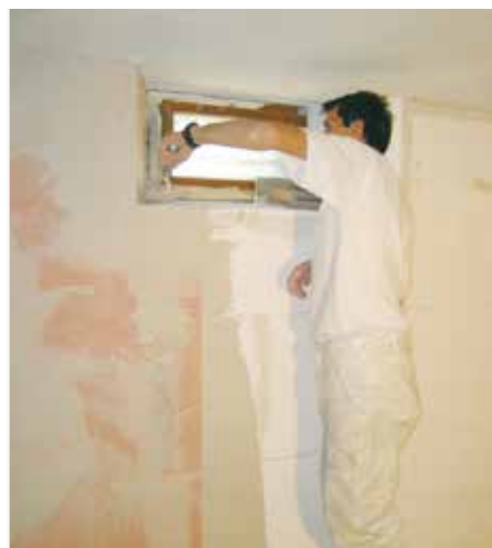
Montage avec RÖFIX Renopor® Element cunéiforme pour plafonds
