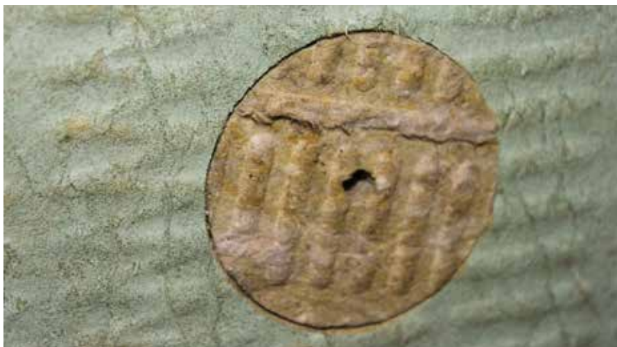
Couvrir la cheville avec RÖFIX Rondelle de recouvrement MW
