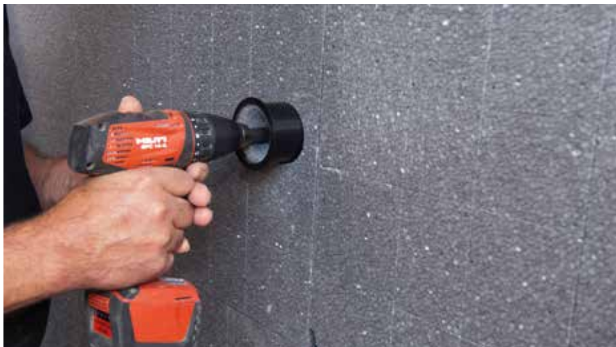
Fraiser jusqu'en butée avec la fraise RÖFIX Zyrillo
