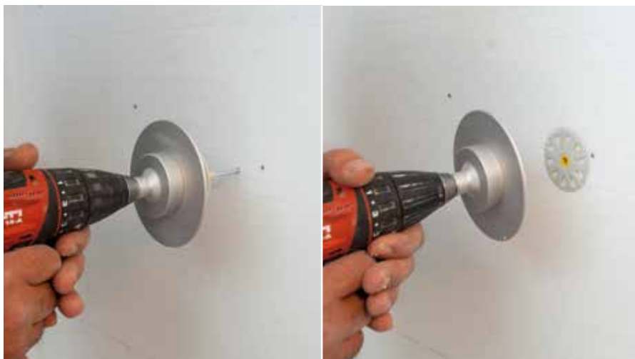
RÖFIX ROCKET WOOD peut également être montée au ras de la surface ou à encastrément sur des panneaux en EPS et laine de roche
