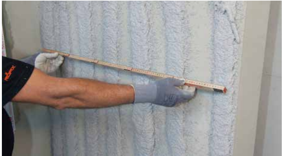
Pulvériser les cordons d'enduit de collage sur le support de 5-6 cm de largeur et respecter une distance de 17 cm entre les lignes médianes
