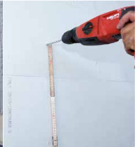
Percer les trous selon un quadrillage de 40x40 cm
