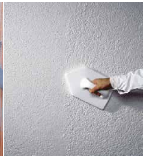
Après un séchage approprié de l'enduit de lissage, appliquer le revêtement mural et structurer
