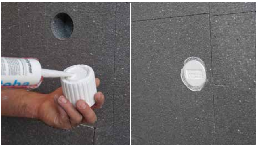
Appliquer la colle PU sur le revers de Zyrillo et sur les parois latérales dans le trou
