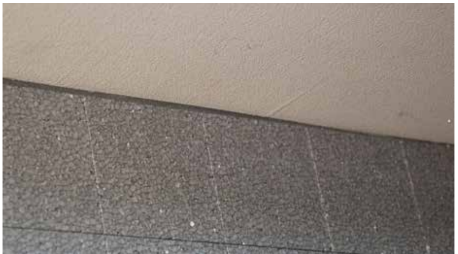
Pendant le collage, bien presser le panneau de la façade contre le ruban d'étanchéité de façon à ce qu'il soit comprimé
