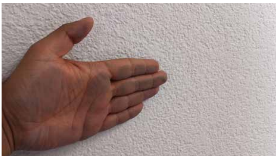
Retirer les supports poudreux, plâtreux et appliquer une couche de fixatif adaptée (RÖFIX PP 201 SILICA LF ou RÖFIX PP 301 HYDRO LF correctement dilués). Retirer mécaniquement les finitions à base de chaux
