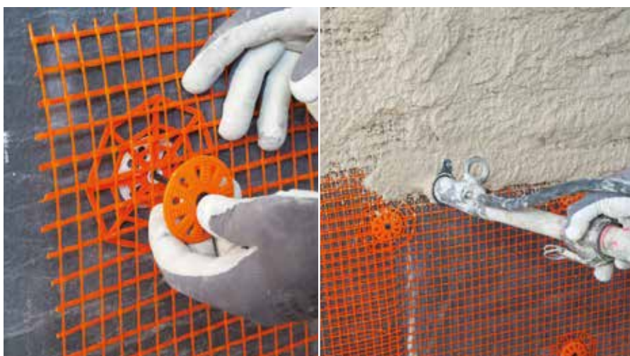
Fixer le treillis de support RÖFIX IG 996 avec RÖFIX BTH et RÖFIX NDF
