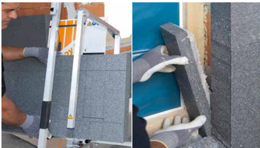
Découper les panneaux avec la coupeuse RÖFIX ISOBOY EX 34-K
