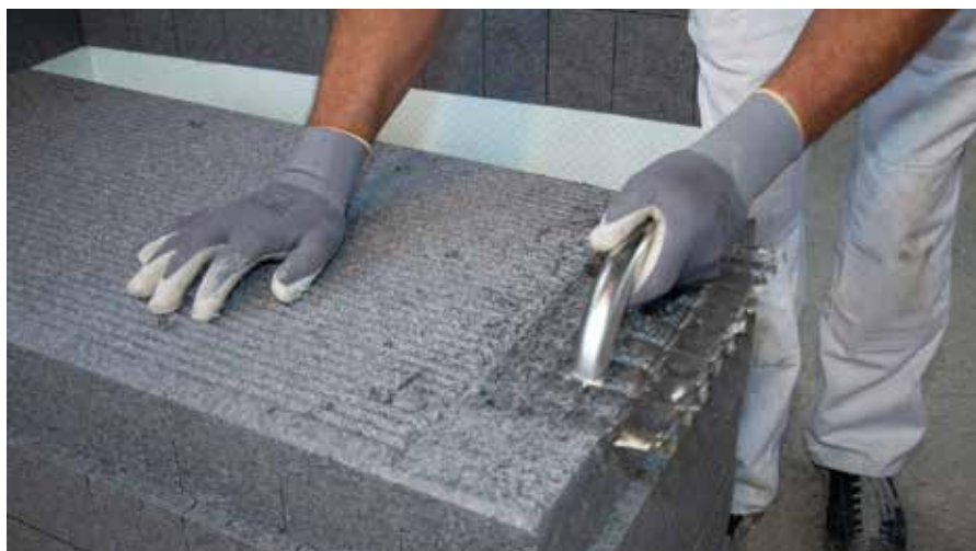
Au niveau des angles du bâtiment, rectifier le moletage take-it
