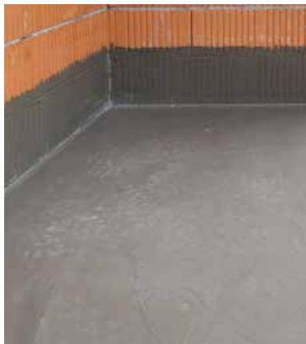
Imperméabilisation de la maçonnerie contre terre et des terrasses avec RÖFIX Optiseal®
