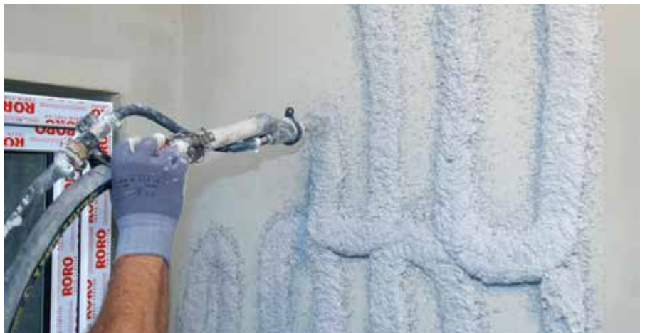
Vérifier que la partie inférieure du cordon d'enduit de collage ferme la cavité en bas. Cela permet d'éviter toute recirculation de l'air sur le revers du système
