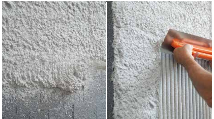
Appliquer l'enduit de lissage au jet avec une guniteuse
