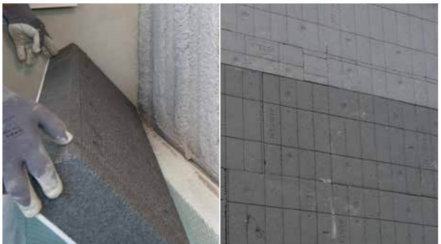
Presser les panneaux isolants contre l'enduit de collage frais en utilisant le moletage take-it
