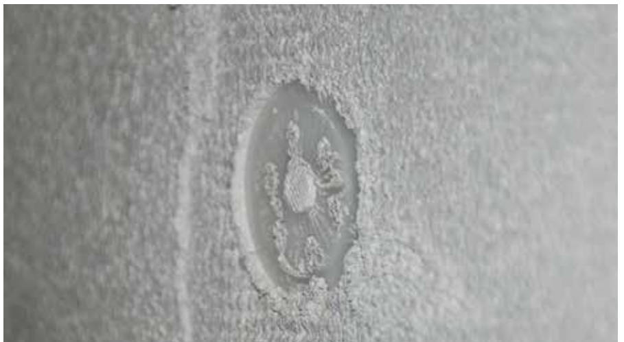
Cheviller à travers la couche d'enduit de lissage avec treillis encore fraîche
