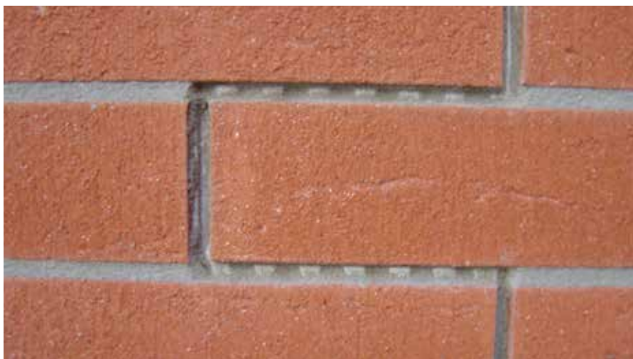
Joint flexible: Éliminer l'enduit de collage frais jusqu'à l'enduit de fond. Utiliser un mastic flexible polyuréthanique approprié (ex. Sika- Primaire 3N et mastic Sikaflex Pro2HP)
