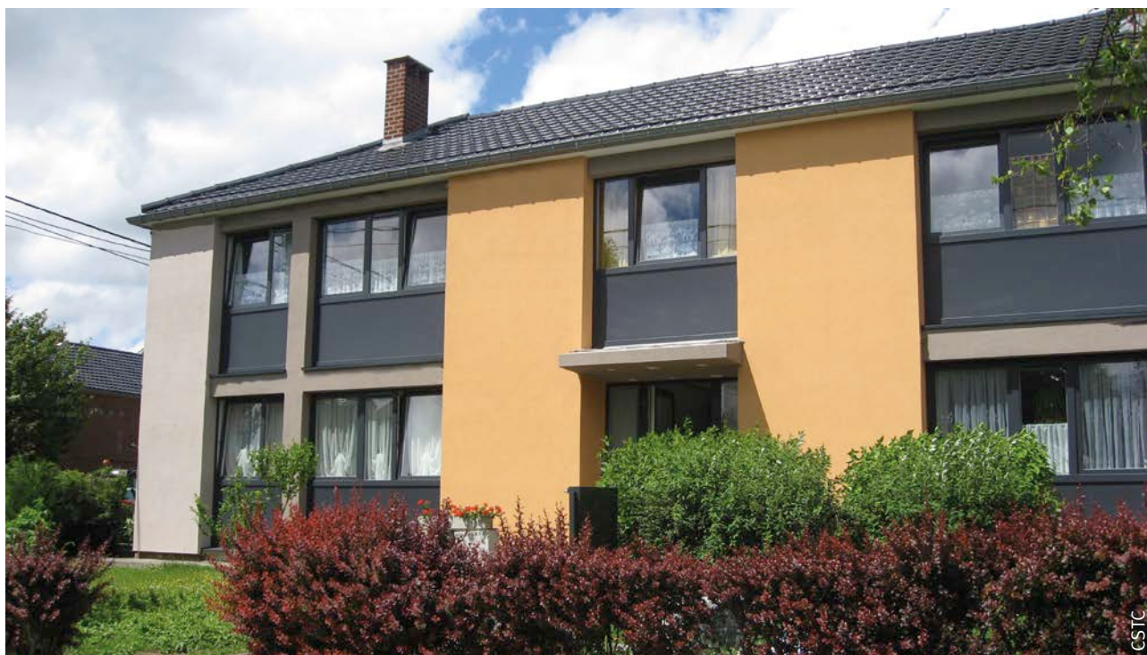
Fig. 1 Exemple de réalisation d'un ETICS.
