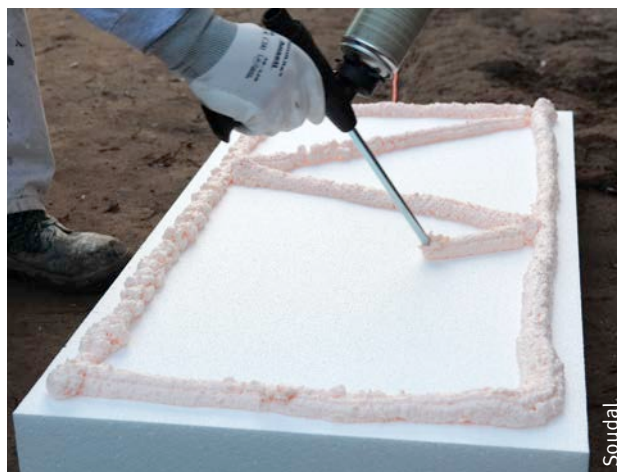
Fig. 114 Application au pistolet d'une mousse-colle polyuréthane sur un panneau isolant.
