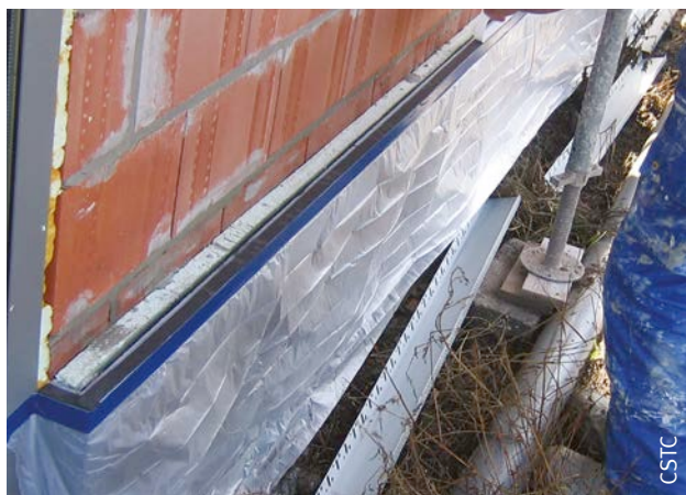
Fig. 95 Pose du préformé d'étanchéité sur la plinthe.
