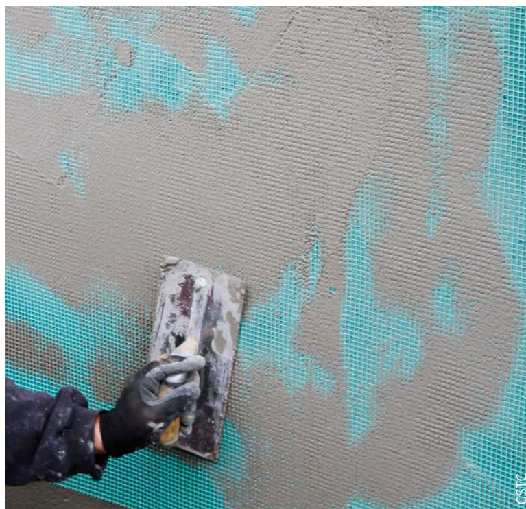
Fig. 3 Mise en œuvre de l'enduit de base renforcé d'un ETICS.
