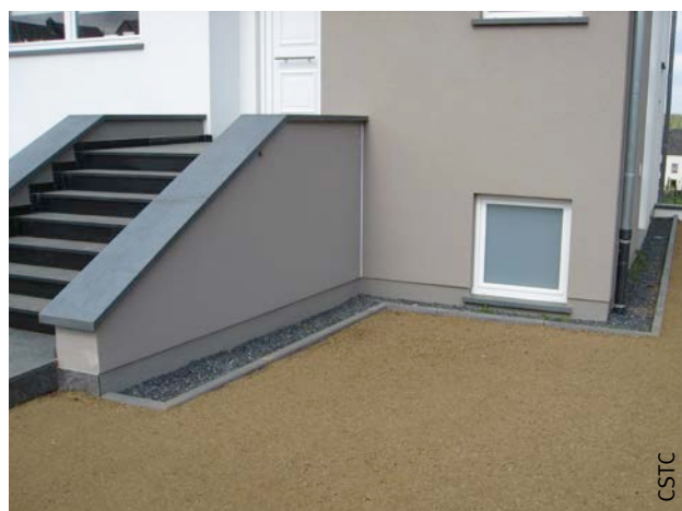
Fig. 44 Pieds de mur traités selon les dispositions constructives spécifiques aux ETICS.
