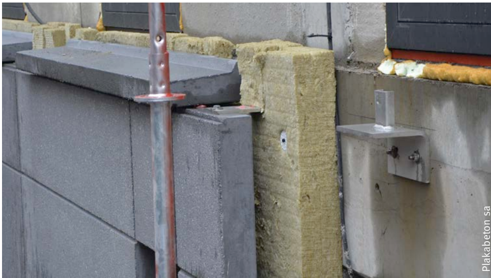
Fig. 84 Exemple de raccord à un mur coulisse.
