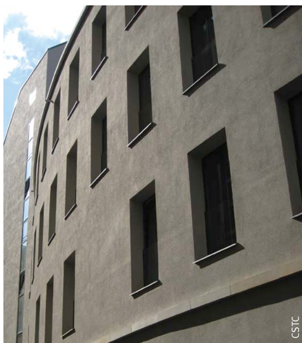
Fig. 51 Pose en battée (recommandée).
