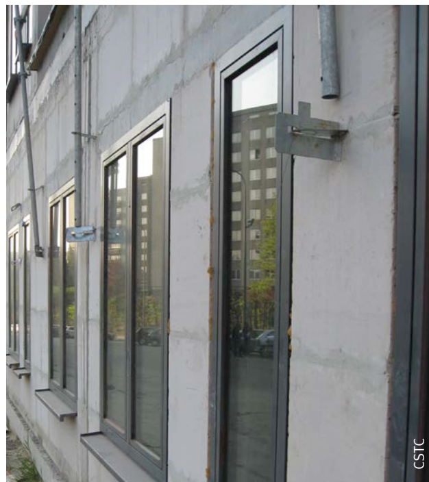
Fig. 54 Pose de la partie fixe du châssis à fleur de la face externe du mur.
