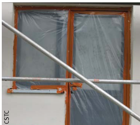
Fig. 93 Protection d'une fenêtre et d'une porte.
