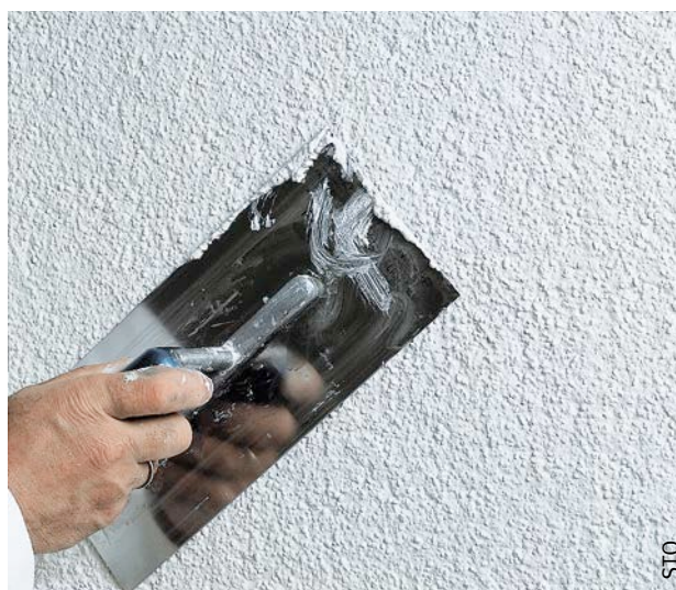
Fig. 136 Grésage d'un enduit de finition mince.
