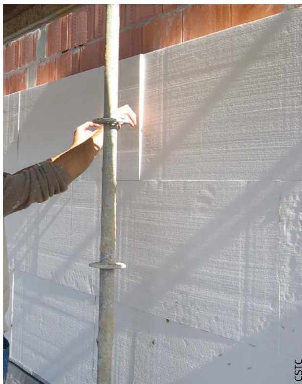
Fig. 101 Pose des panneaux à joints verticaux alternés.
