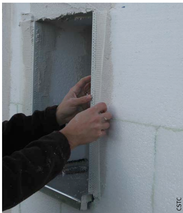
Fig. 124 Pose d'un profilé d'angle.
