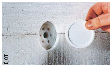
Fig. 116 Pose d'une fixation au cœur de l'isolant.
