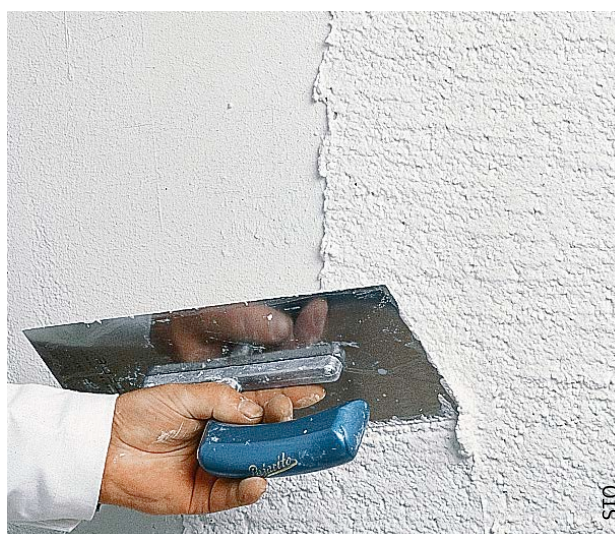
Fig. 135 Mise en œuvre d'un enduit de finition (talochage).
