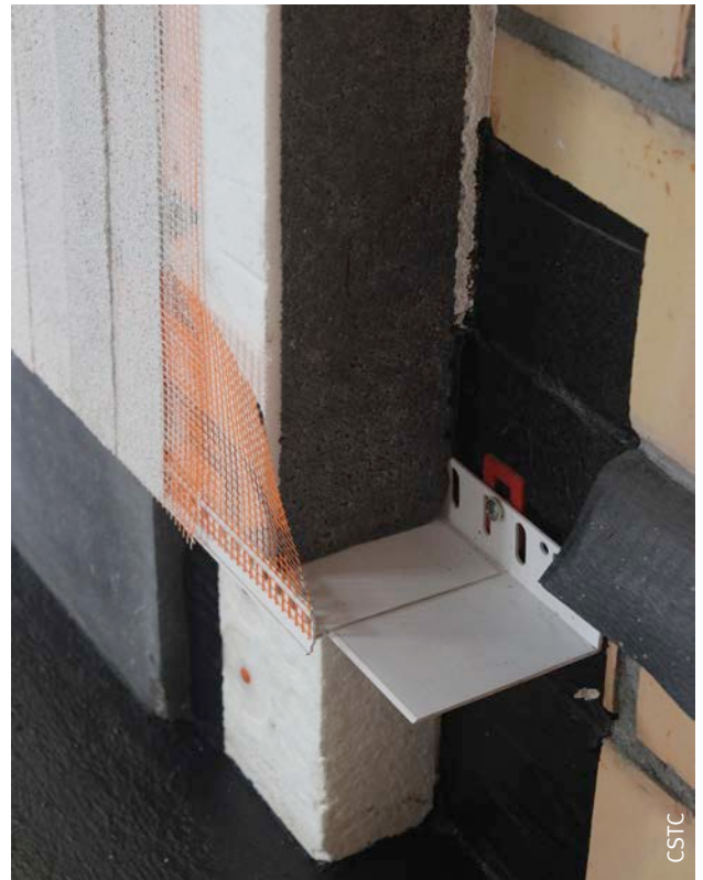
Fig. 46 Plinthe encollée sur l'isolant de socle.
