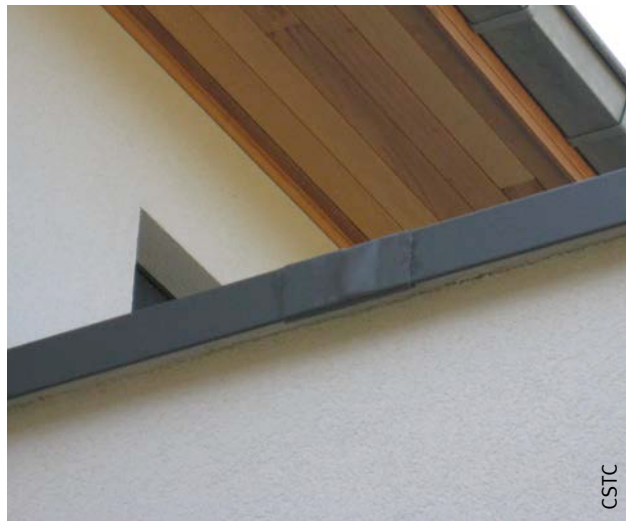
Fig. 67 Raccord à la rive d'une toiture plate.
