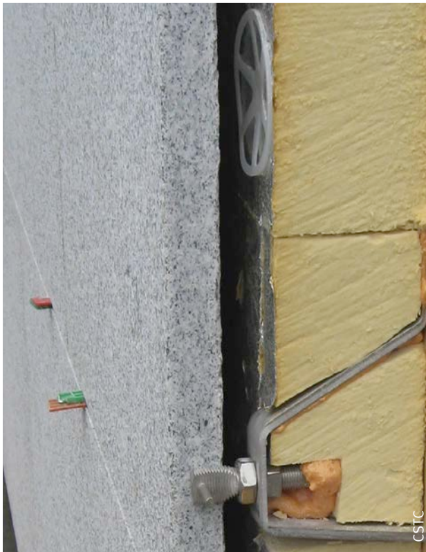
Fig. 45 Pierre naturelle agrafée et isolant de socle pour le parachèvement du soubassement.
