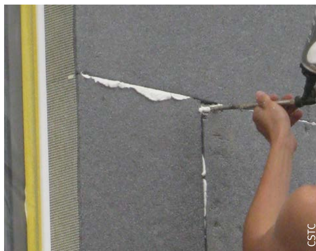
Fig. 121 Remplissage des joints entre panneaux au moyen d'une mousse PU expansible adaptée.
