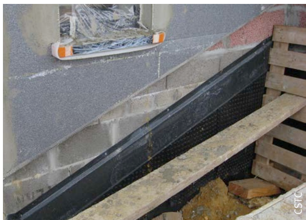
Fig. 97 Pied de mur en pente.
