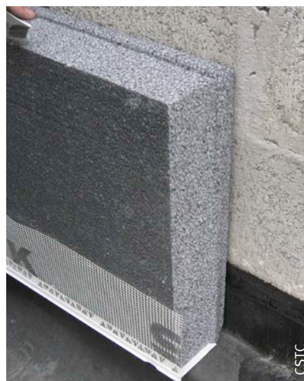
Fig. 64 Raccord au départ de toitures plates.
