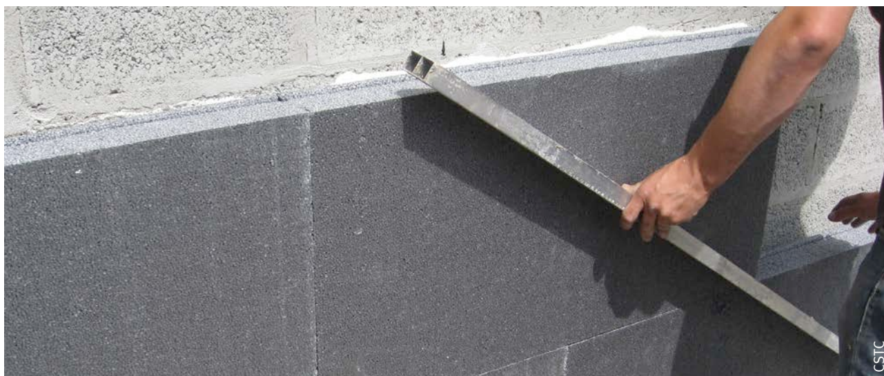
Fig. 2 Mise en œuvre des panneaux d'un ETICS.
