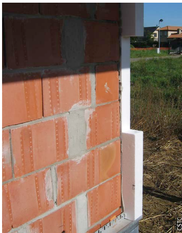
Fig. 103 Harpage dans les angles du bâtiment.
