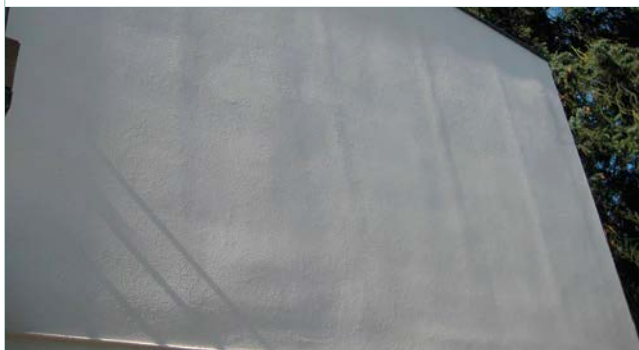
Apparition de la trame du recouvrement des armatures.
