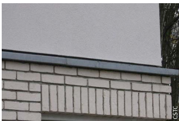
Fig. 82 Raccord d'un ETICS à un mur coulisse.
