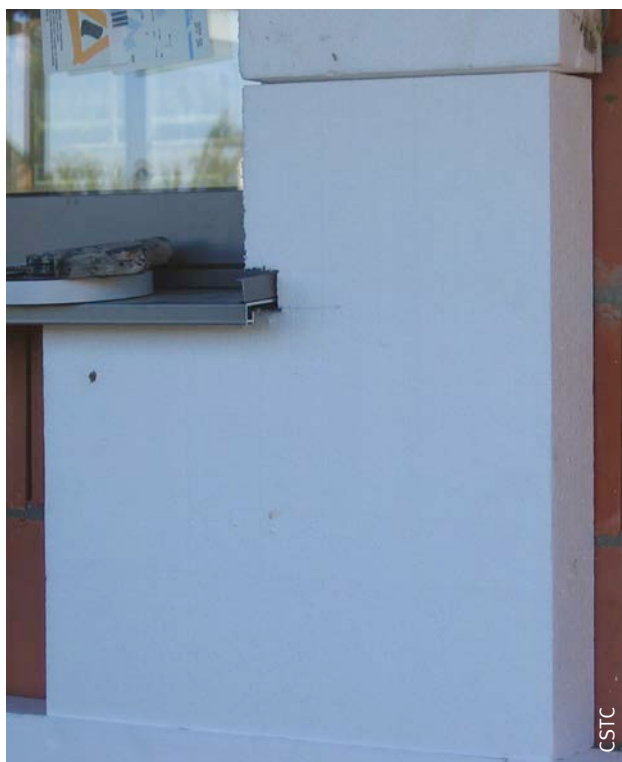
Fig. 109 Pose d'un panneau prédécoupé en une seule pièce dans un angle de baie.
