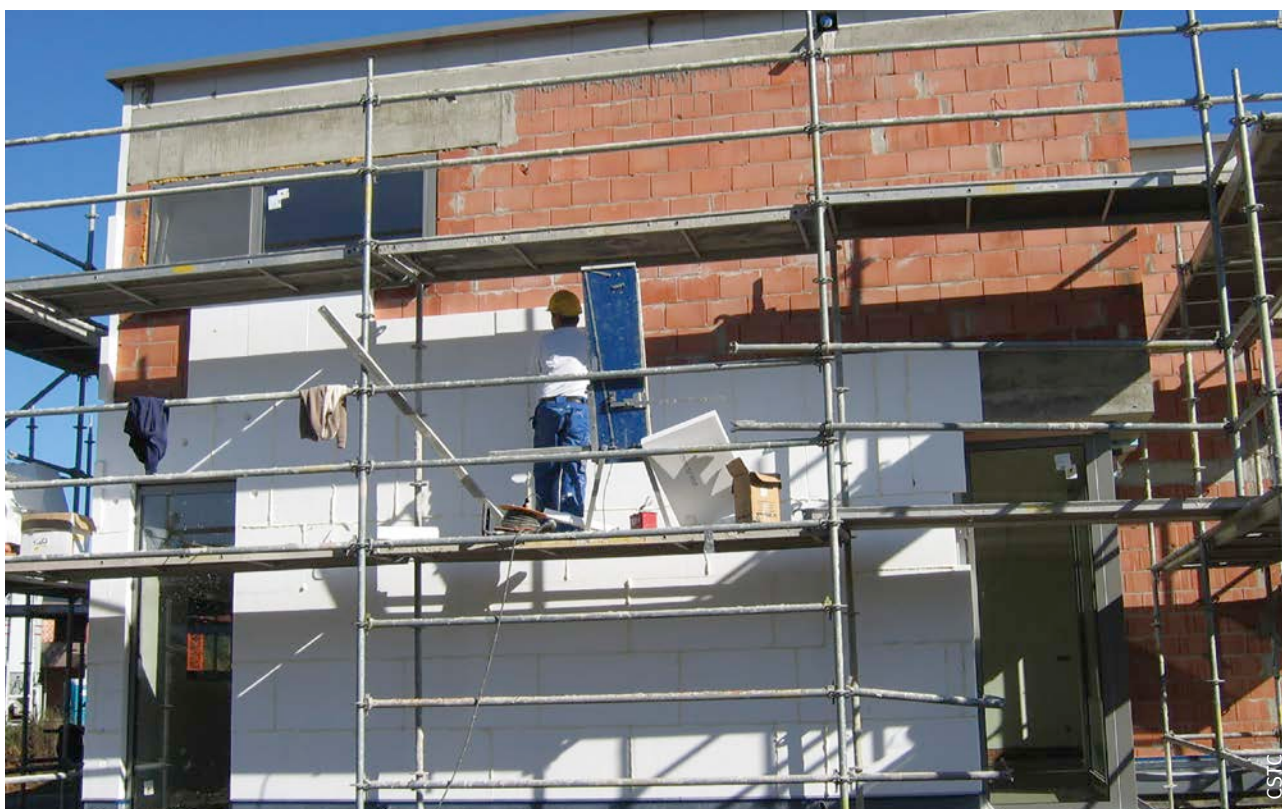
Fig. 13 Pose d'un isolant sur une façade extérieure.
