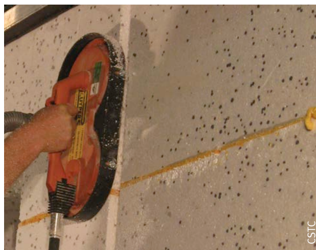
Fig. 122 Ponçage de la surface d'isolation (panneaux en EPS).
