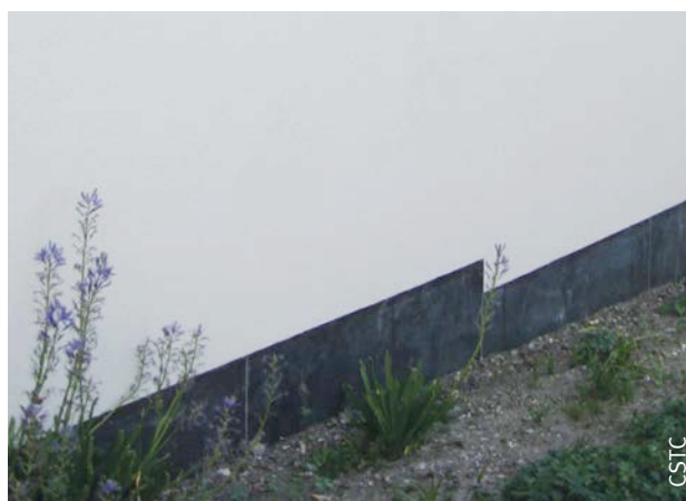
Fig. 98 Pied de mur en escalier.
