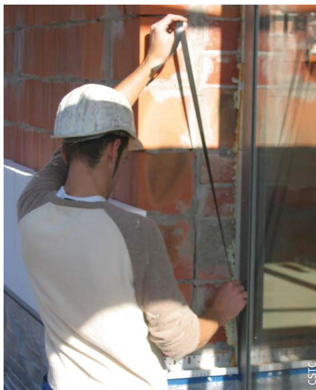
Fig. 110 Pose d'une bande d'étanchéité comprimée (fond de joint) à la jonction entre le panneau isolant et le dormant du châssis.
