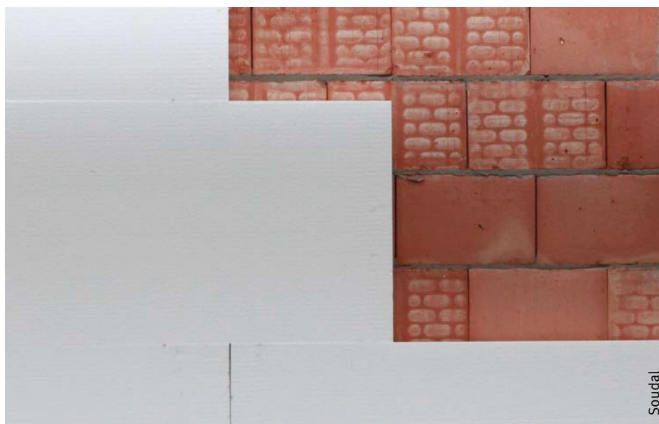
Fig. 99 Pose bien ajustée à joints verticaux alternés des panneaux aux tolérances dimensionnelles adaptées.
