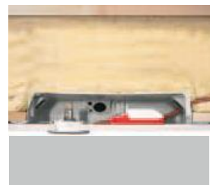
1 Schuimafdichting | 2 ECON®-invoer | 3 EnoX® behuizing
