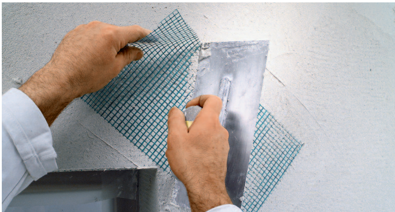
Afb. 19: Aanbrengen van diagonaalstroken.
