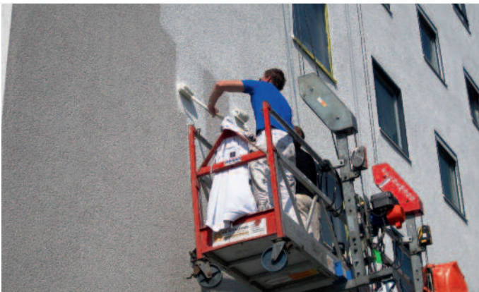
Afb. 29: Aanbrengen van verflaag.
