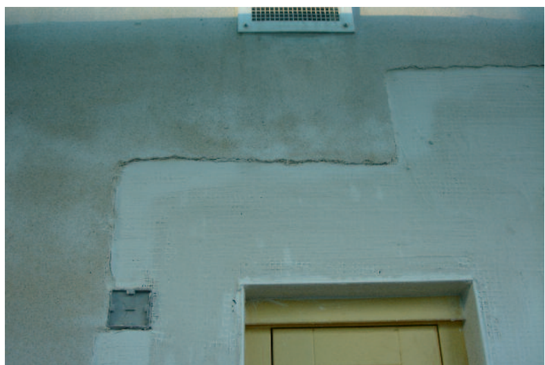
Afb. 30: Plaatselijke herstelling van wapeningslaag
