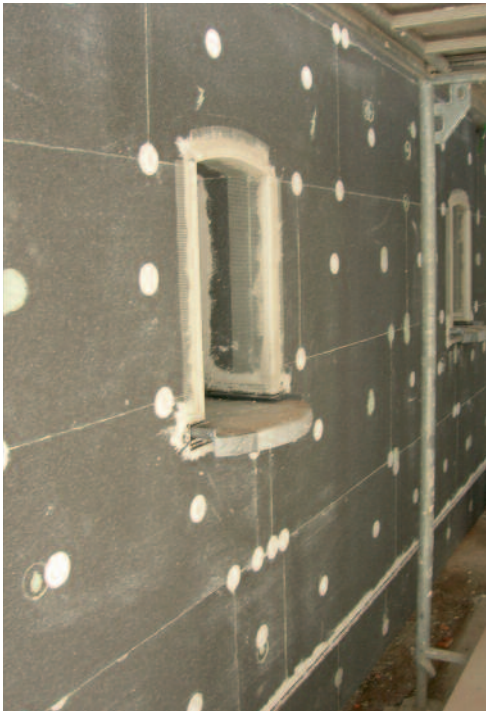
Afb. 15: Extra verankering van de isolatie.
