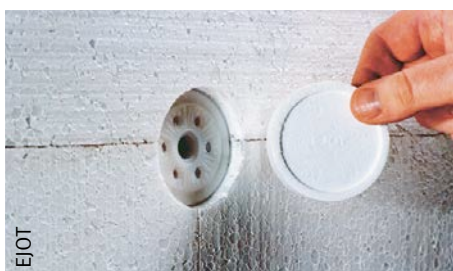
Afb. 116 Plaatsing van een bevestiging verzonken in de isolatie.
