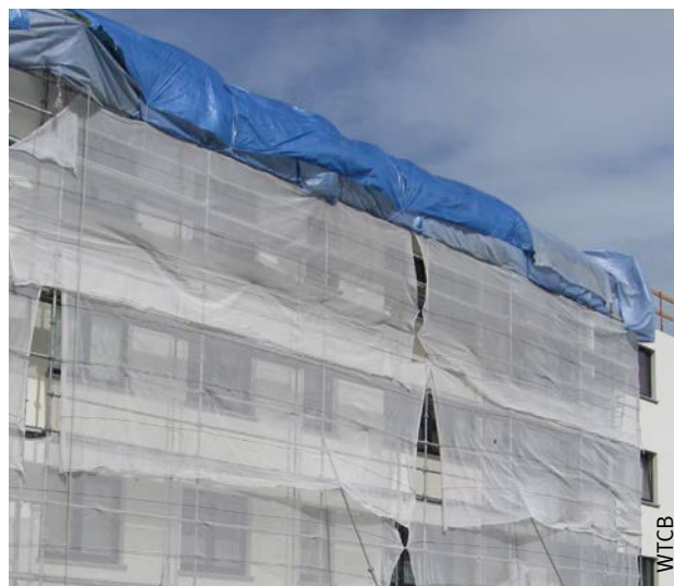
Afb. 94 Dekzeilen voor bescherming tegen de zon en de wind.
