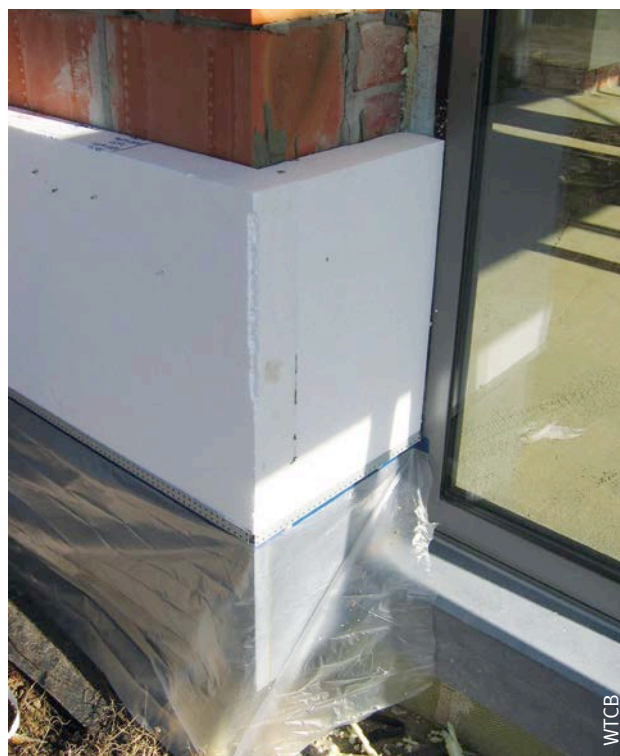
Afb. 112 Plaatsing van de isolatie tegen de zwelband met het oog op de samendrukking ervan.
