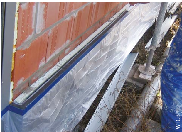
Afb. 95 Plaatsing van een zwelband op de plint.
