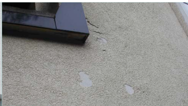
Het falen van de detaillering ter hoogte van de dorpel wat leidt tot waterinfiltraties in de bepleistering, blaasvorming en onthechtingen.
