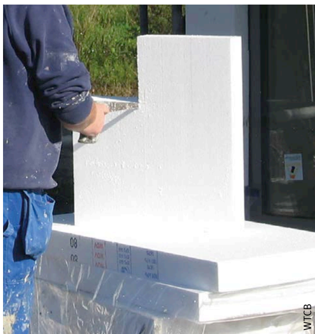
Afb. 107 Aangepast versnijding vóór de plaatsing van de plaat in de hoek van een dagopening.
