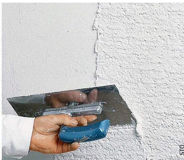
Afb. 135 Aanbrengen van een afwerkpleister (uitsmeren).
