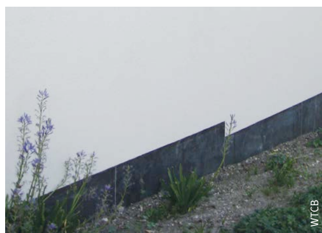
Afb. 98 Trapvormige muurvoet.
