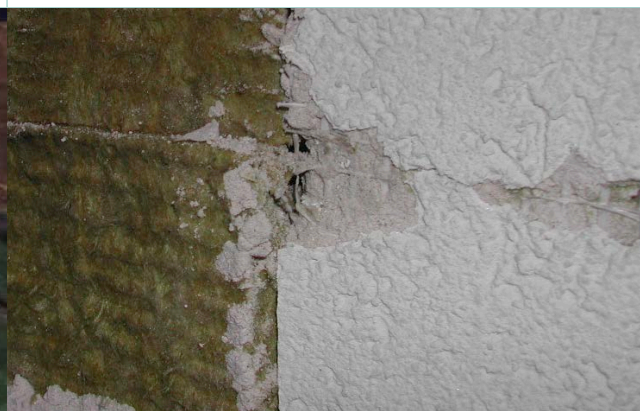
Aftekening van de voegen tussen de isolatieplaten aan het oppervlak van het ETICS, wat wijst op de dimensionale onstabiliteit van de isolatie.
