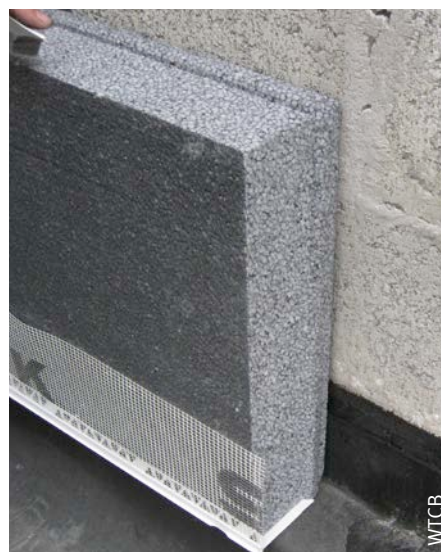
Afb. 64 Aansluiting aan de aanzet van platte daken.
