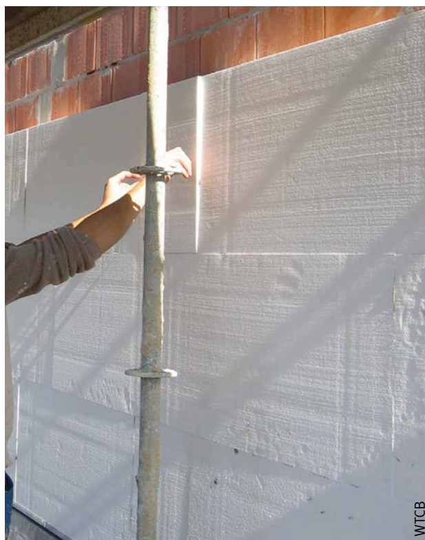
Afb. 101 Plaatsing van isolatieplaten met verspringende verticale voegen.
