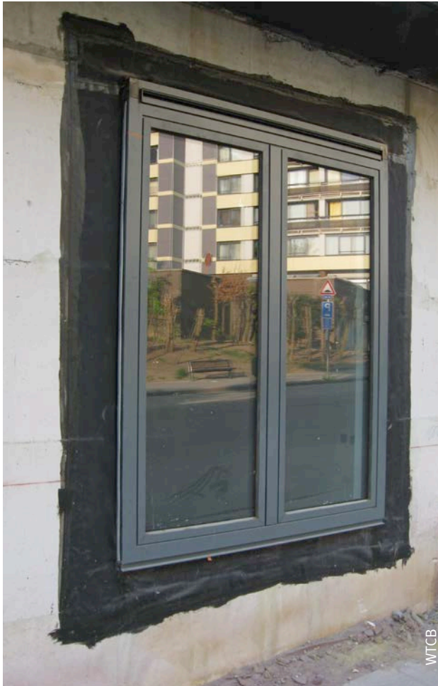
Afb. 56 Luchtscherm tussen het schrijnwerk en de muur.
