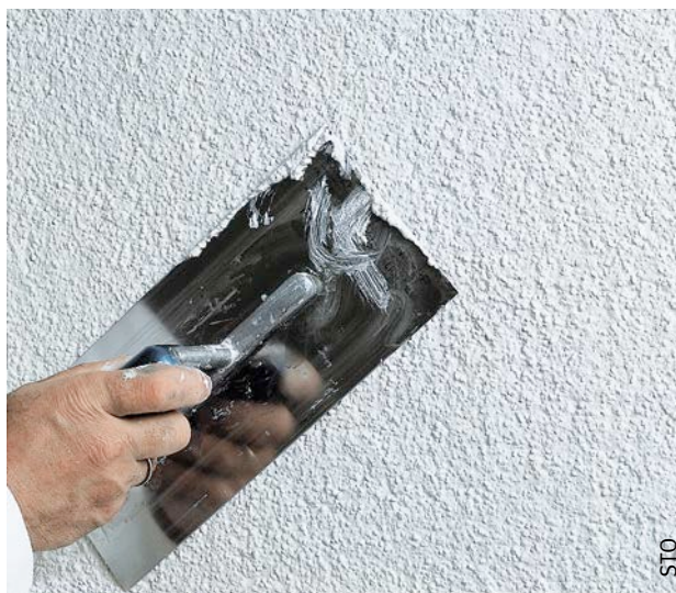
Afb. 136 Gladmaken van een dun afwerkpleister.
