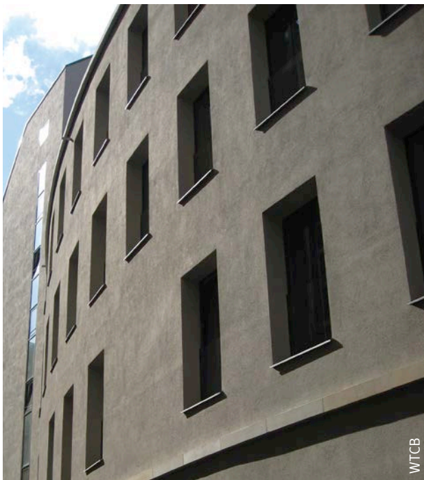
Afb. 51 Plaatsing in neg (aanbevolen).
