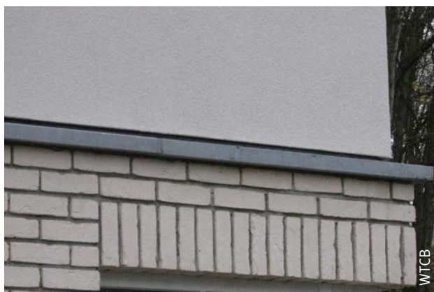
Afb. 82 Aansluiting van een ETICS met een spouwmuur.
