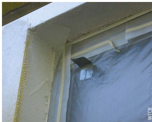
Afb. 125 Plaatsing van een profiel met een versnijding van het profiel en van het gelaste wapeningsweefsel, waardoor men de continuïteit van de wapening kan verzekeren ter hoogte van de binnenhoek.
