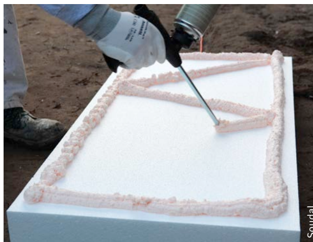
Afb. 114 PU-lijmschuim dat met een pistool wordt aangebracht op een isolatieplaat.
