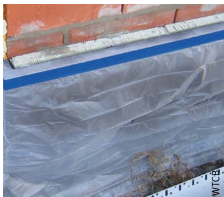
Afb. 92 Bescherming van een plint.
