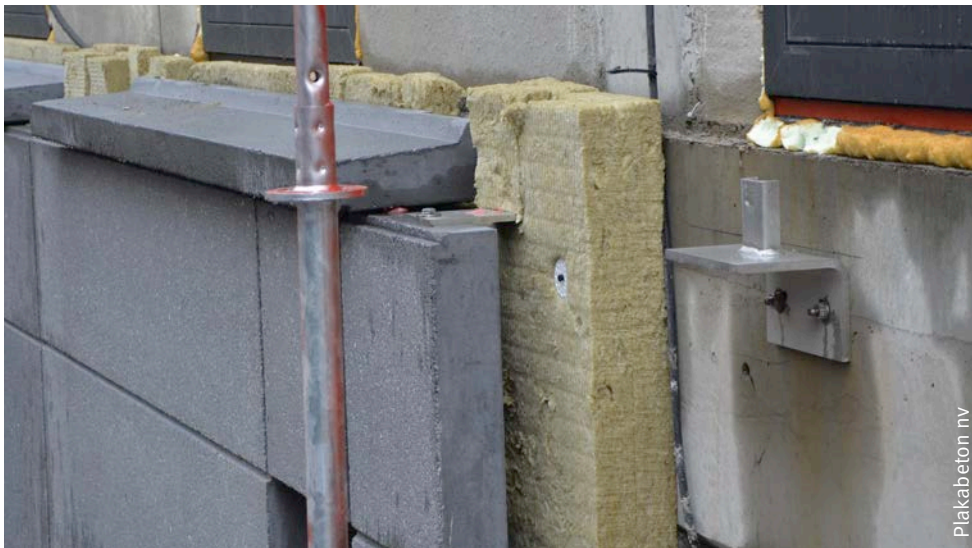
Afb. 84 Voorbeeld van een aansluiting met een spouwmuur.
