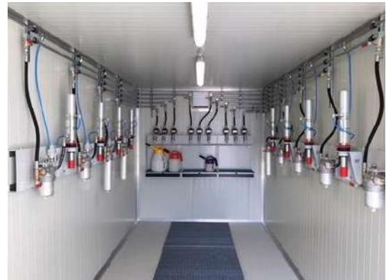
Separate druckluftbetriebene Transferpumpen, Filter, Rohrleitungen und Flexibles für jedes einzelne Öl. Schmierstoffzapfleiste mit Auslaufschutz und Rückhaltung, optional mit Farbcodierung und digitaler Überwachung. Umfüllung aus Standard-Ölfässern des Schmierstofflieferanten (200 L, 50 L, 20 L). Inline-Filtration bis zu 3 Mikron, Trockenmittel-Entlüfter, Probenahmestellen, digitale Verbrauchsmessung.
