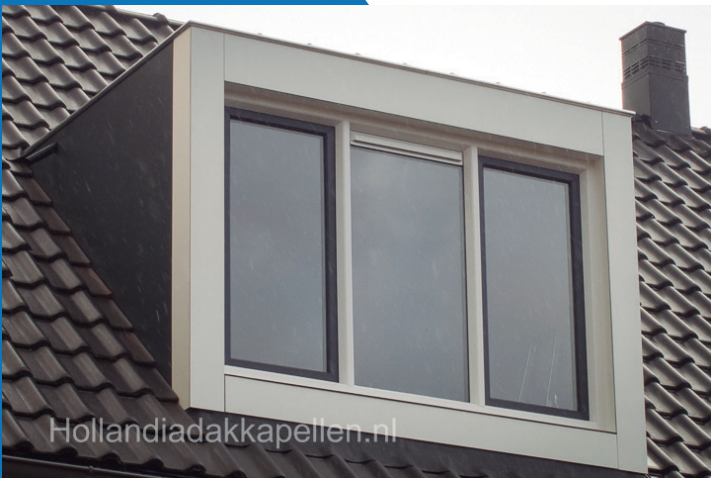
Dakkapel speciale bouw – Trespa
