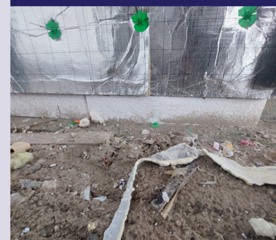
Foto aansluiting isolatie op vloer.
