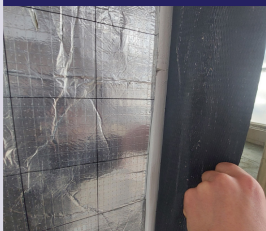
Foto aansluiting isolatie op kozijn.
