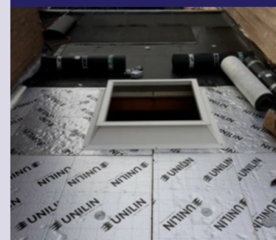
Foto aansluiting isolatie op dakraam.
