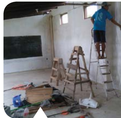
De werkzaamheden zijn in volle gang.
